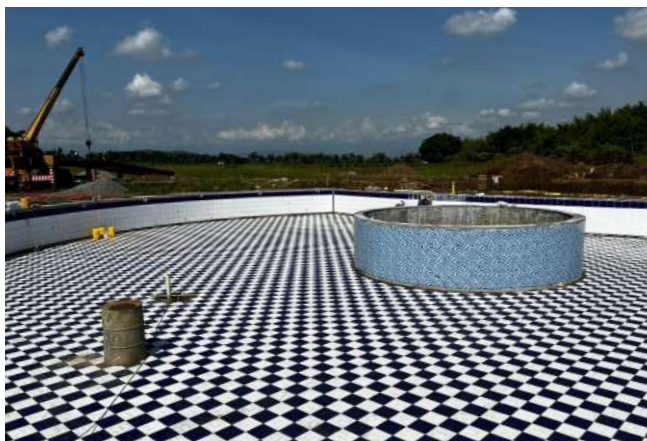
La construcción del centro recreativo Caña Dulce en Santander de Quilichao, avanza rápidamente.
