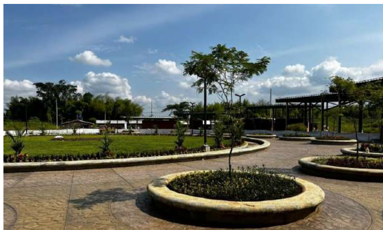
La construcción del centro recreativo Caña Dulce en Santander de Quilichao, avanza rápidamente.
