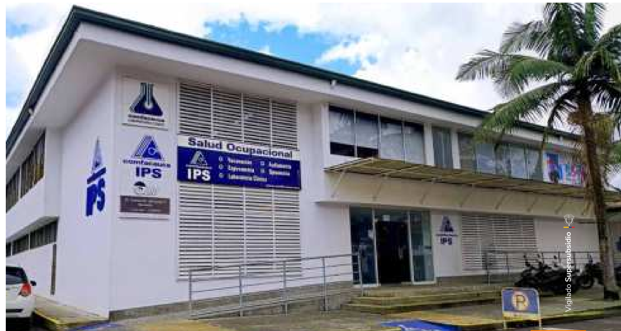
Instalaciones IPS Comfacauca Popayán
